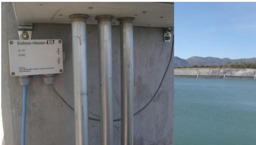
Imagen 1. Waterpilot en México. La caja de conexiones proporciona una conexión segura y directa de la sonda de nivel con el sistema de control.
